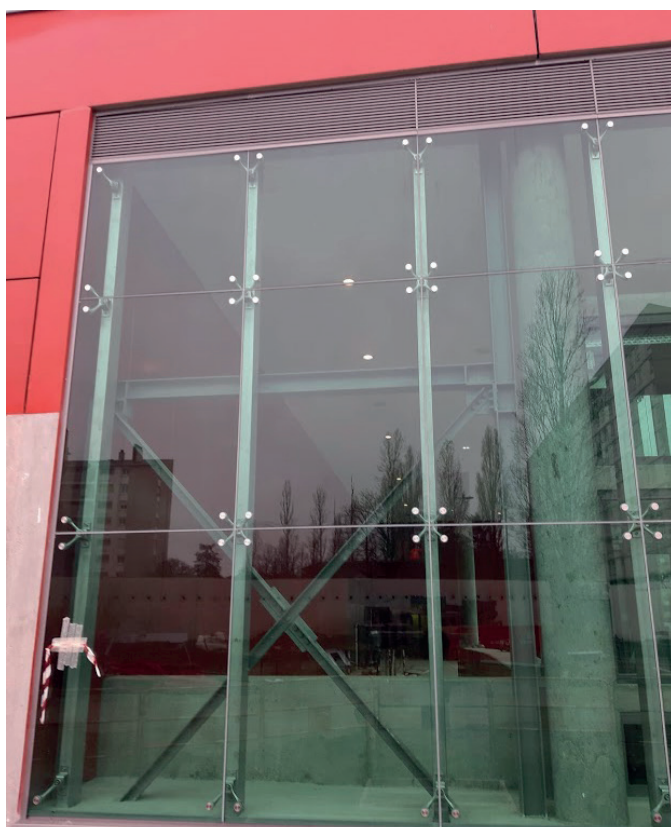
Chantier réalisé avec le système 421 KS
