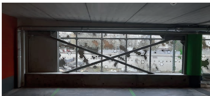
Chantier réalisé avec le système 421 KS
